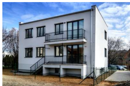
Novostavba se 3 byty, Bílovice n. Svitavou
