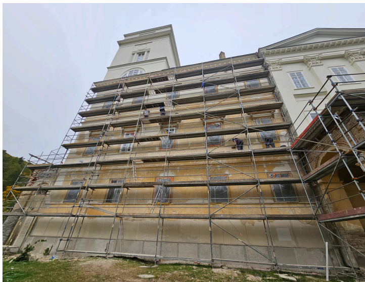
Hlavní zámecká budova v průběhu rekonstrukce fasády
