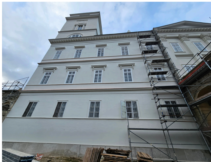
Hlavní zámecká budova po rekonstrukci fasády
