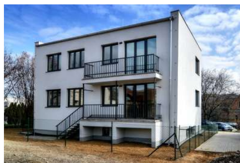
Novostavba se 3 byty, Bílovice n. Svitavou
