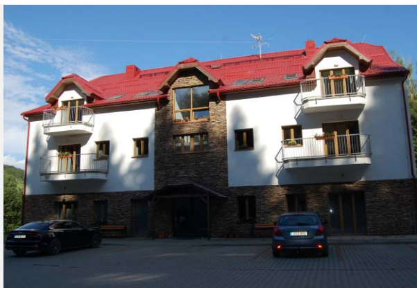
Pohled z parkoviště – hlavní vchod
