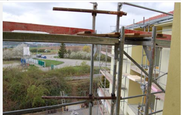
Pohled z balkónu 3.NP
